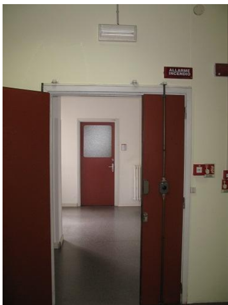
Uscita di emergenza priva di segnaletica "Uscita di emergenza" e con apertura in senso opposto all'esodo.
